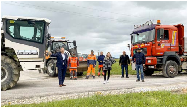
Der Straßenabschnitt Lobenstein wird generalsaniert.
