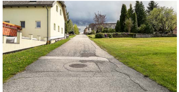
Die alte Gemeindestraße am Galgenbühl wird erneuert.
